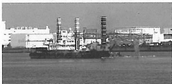
写真1 バックホウ浚渫船への適用
